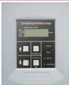
Zentralen-Parallel-Anzeige im formschönen Kunststoff-Aufputzgehäuse als zusätzliche Anzeige zur Brandmeldeanlage. Die Ansteuerung erfolgt über die serielle Schnittstelle der Brandmelderzentrale.
